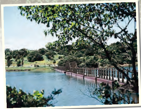
▲白岳公園フロート橋
